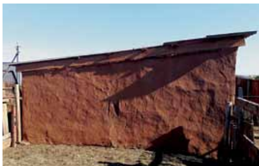
Дворовая постройка из самана в д. Мрясово Новосергиевского р-на Оренбург. обл.
